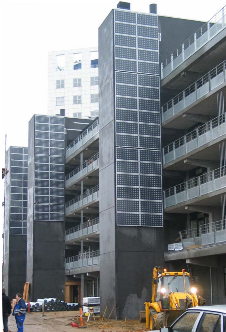
Fig. 3. Der er etableret 200 m 2 solceller på trappetårne i Dalgsparken byggeriet.
