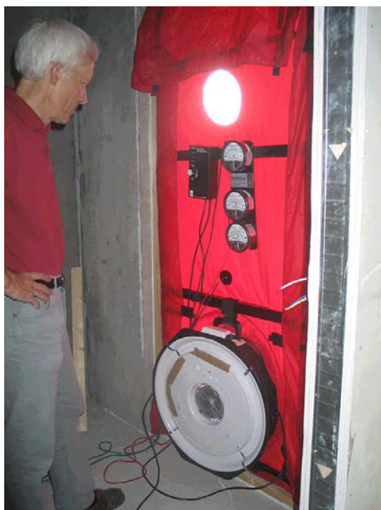
Fig. 1. Blowerdoor test i lejlighed.
