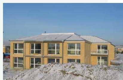
Foto: Peder Vejsig Pedersen, Cenergia Sydfacade med solcelle- og solfangeranlæg.
