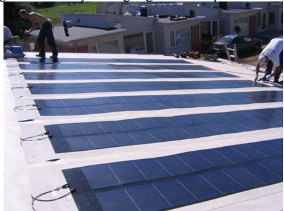
Fælleshus i Solengen, Hillerød med Sarnafiltag og påsvejsede tyndfilm solceller af Unisolar typen.
