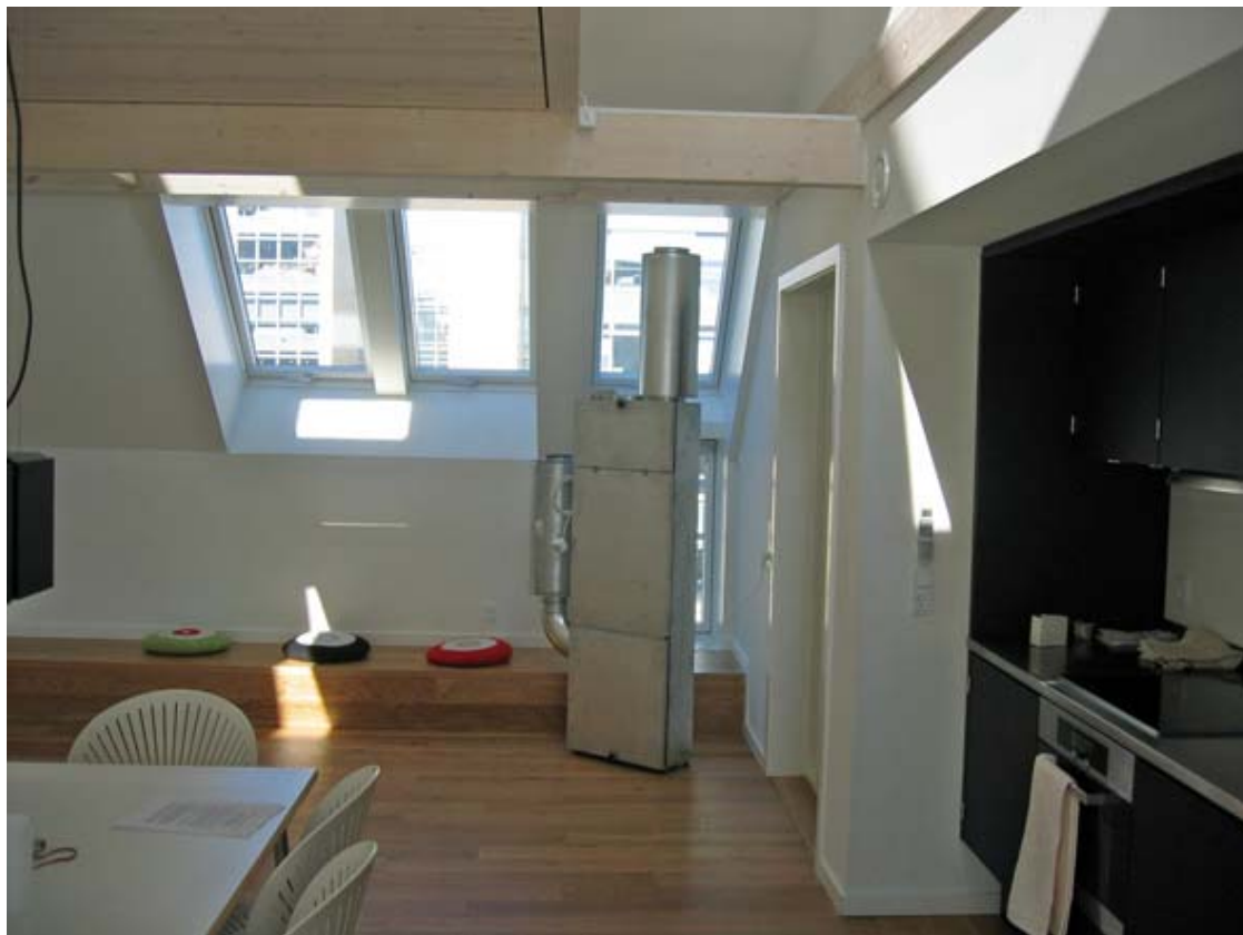
Fig. (5) Eksempel på tynd R200 genvinder her præsenteret for partnere i EU-Demohouseprojektet i den CO 2 neutrale tagbolig i Ørestaden.
