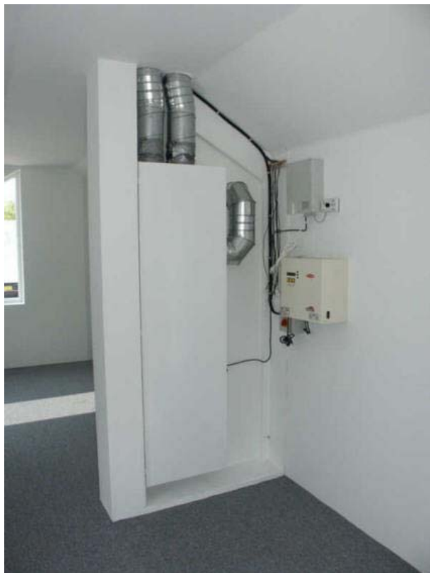
Fig. (2) Eksempel på tynd varmegenvinderenhet placeret i forbindelse med skillevæg.
